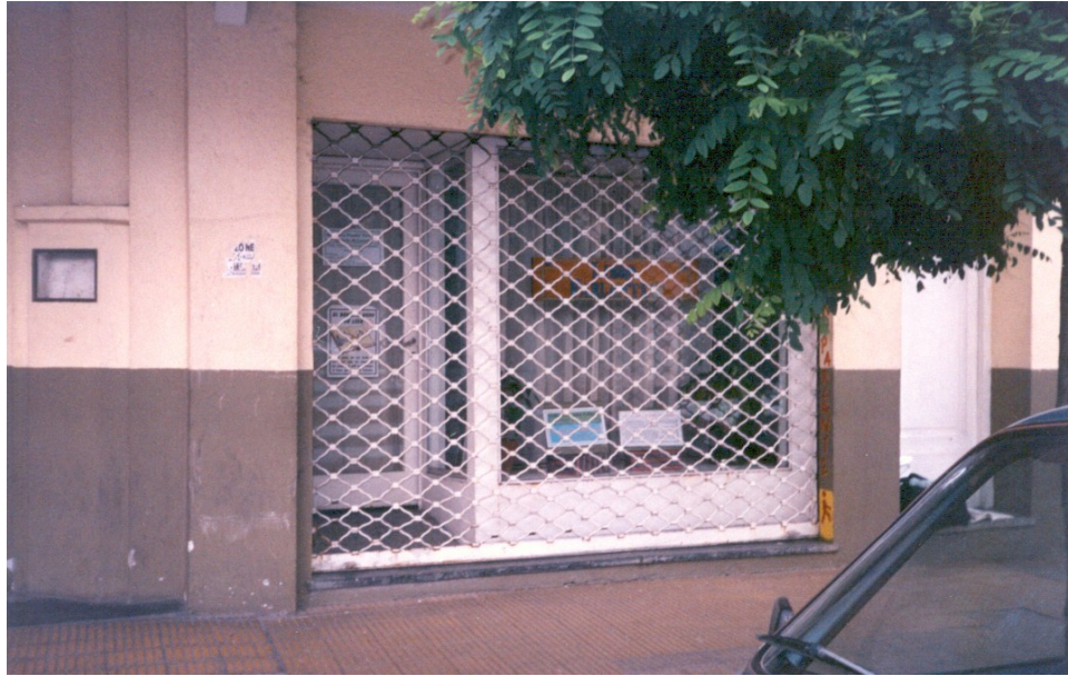
Figura 1. Edificio de Biblioteca para personas ciegas y disminuidas visuales. Se trata de un local diseñado para un comercio pequeño.
